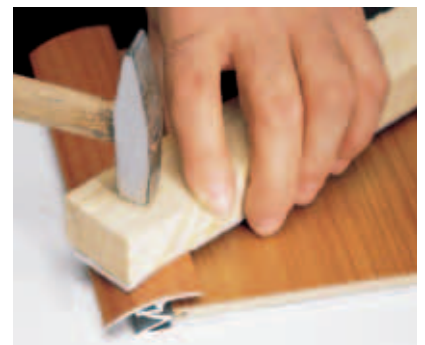
poklepem přes dřevo kladívkem dejte profil do požadované pozice tak aby profil byl zároveň s podlahou
