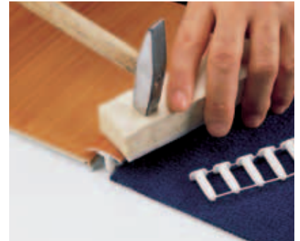
poklepem přes dřevo kladívkem dejte profil do požadované pozice
