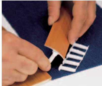
zasuňte hmoždinku do vodící drážky profilu
