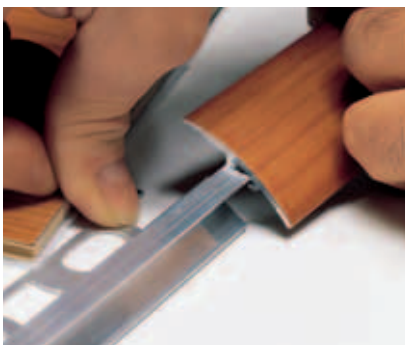
zasuňte základní profil do horního profilu
