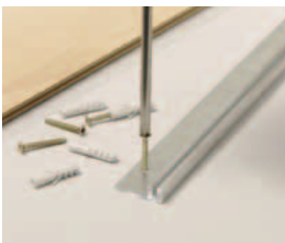
vyvrtejte díry do podlahy a přišroubujte základní profil
